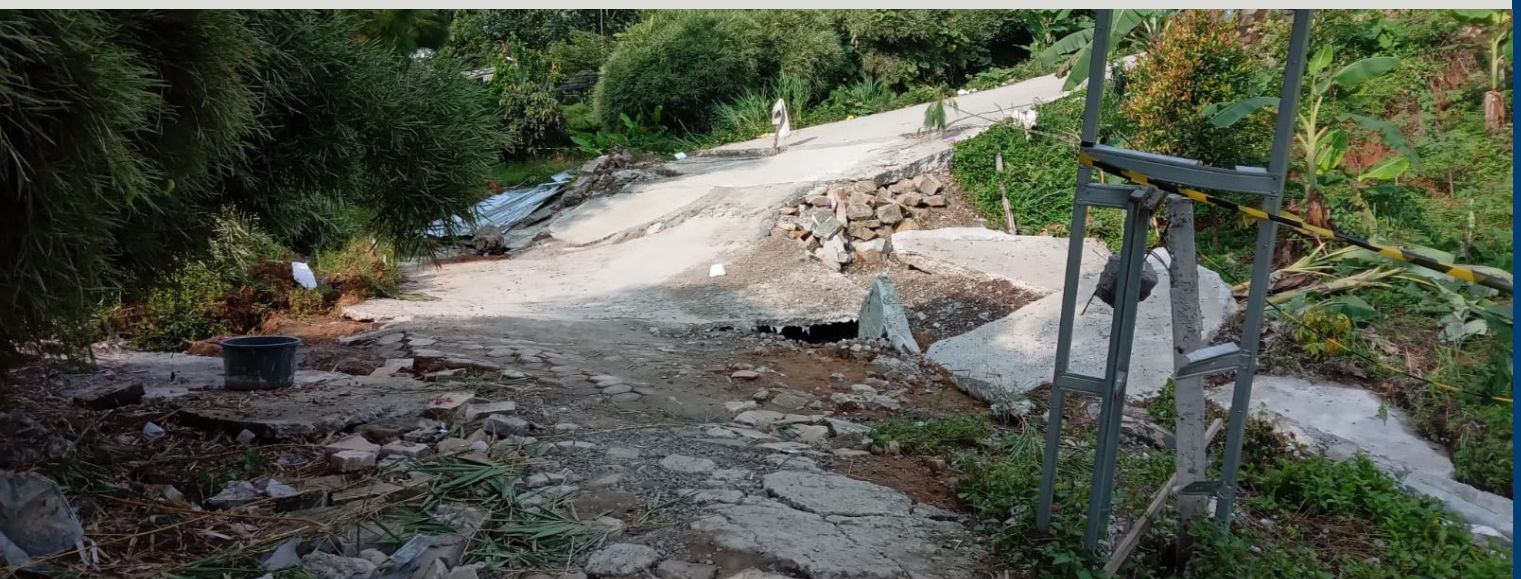
Retakan akibat pergeseran tanah yang terjadi di Kampung Curug, Desa Bojong Koneng, Kecamatan Babakan Madang, Kabupaten Bogor pada 14 September 2022. (Sumber foto: Tim SRC BIG).
