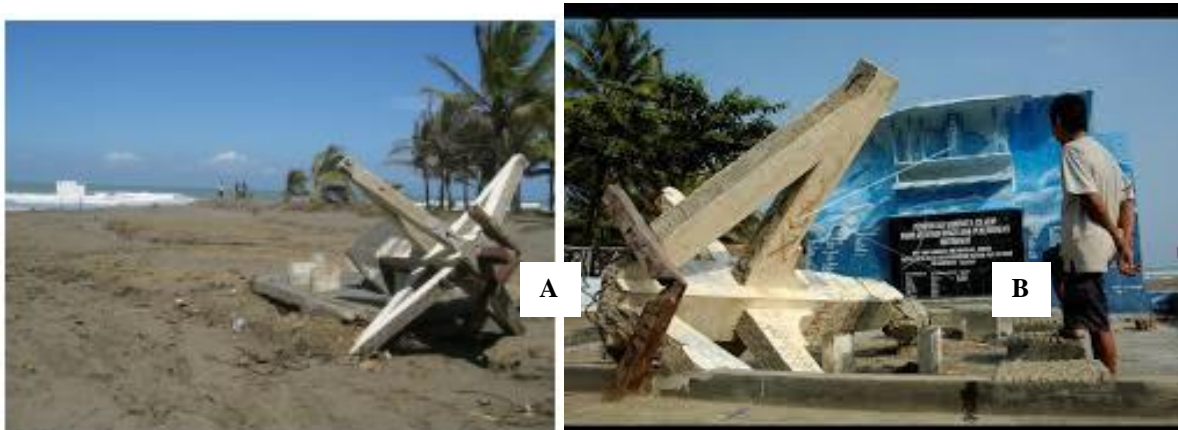
Gambar 1. Kerusakan infrastruktur akibat Tsunami 2006 di Selatan Jawa. A). Bangunan rest area hancur pasca tsunami di Pantai Widarapayung B). Monumen Tsunami di Widarapayung, Cilacap (Gunawan & Widiyantoro, 2019).
